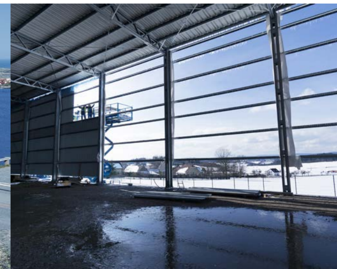
Profilene monteres på plassen ved boltet forbindelse i hull som stanses i produksjonen
